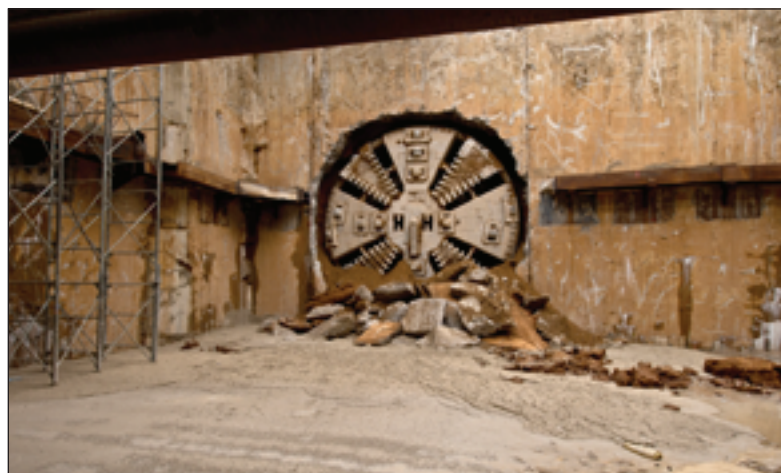
Выход тоннелепроходческого щита на станции Румянцево.
